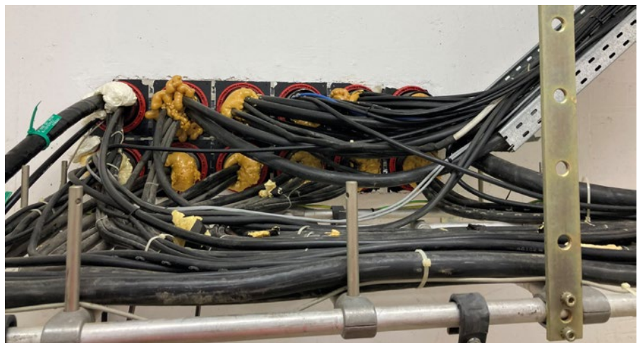
Abb. 3: Ebenfalls fehlerhaft: eine Abschottung mit Bauschaum
